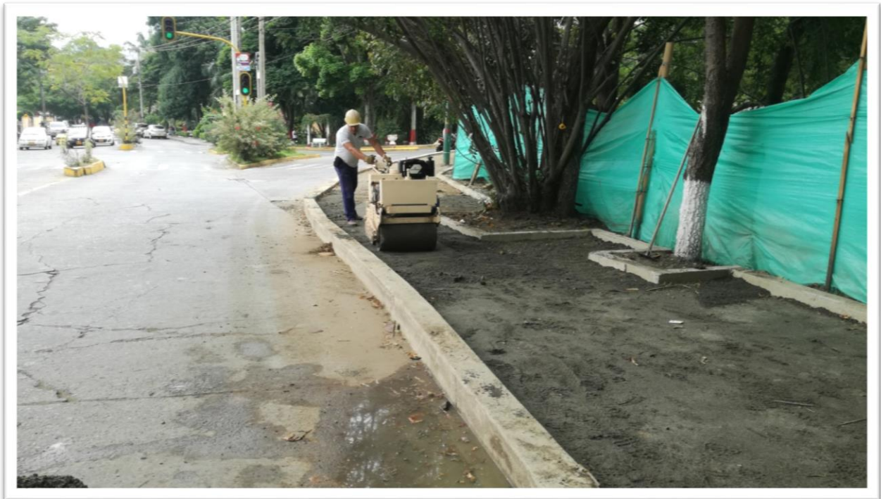
Figura 17. área compactada y nivelada.
