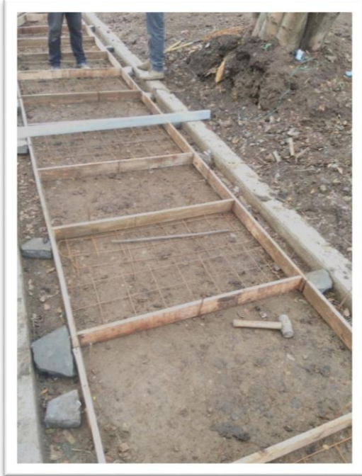
Figura 23. senderos en concreto estampado, concreto 3000 psi, malla electro soldada
