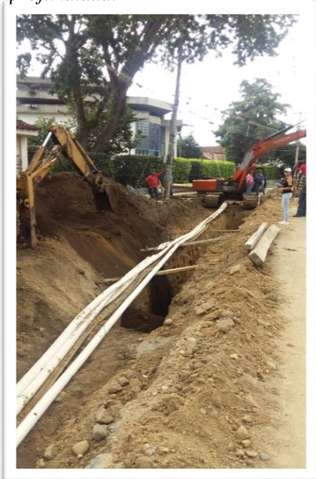
Figura 49. excavación de 7m de profundidad.
