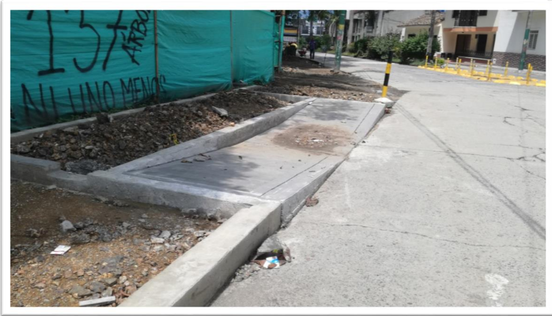
Figura 22. fundición de rampas concreto 3000 psi
