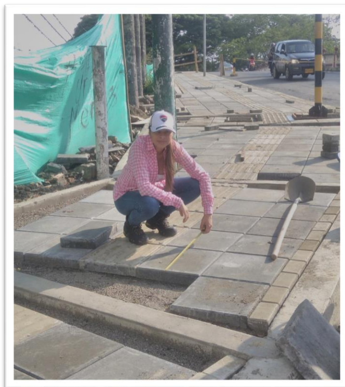
Figura 20. trabajo de campo. verificación de medidas
