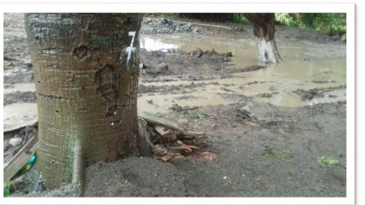
Figura 27. presencia de lodo e inundaciones por lluvias
