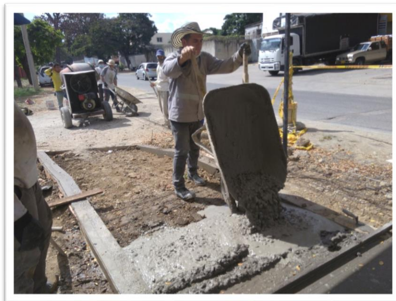
Figura 52. fundición de anden perimetral en concreto de 3000 psi
