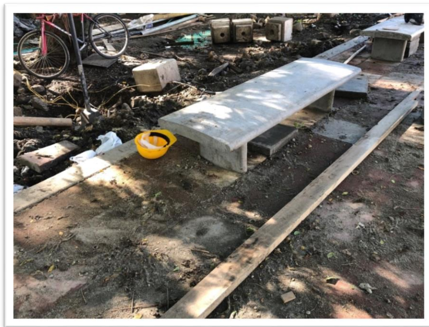
Figura 13. suministro e instalación banca de concreto 2.0 m
