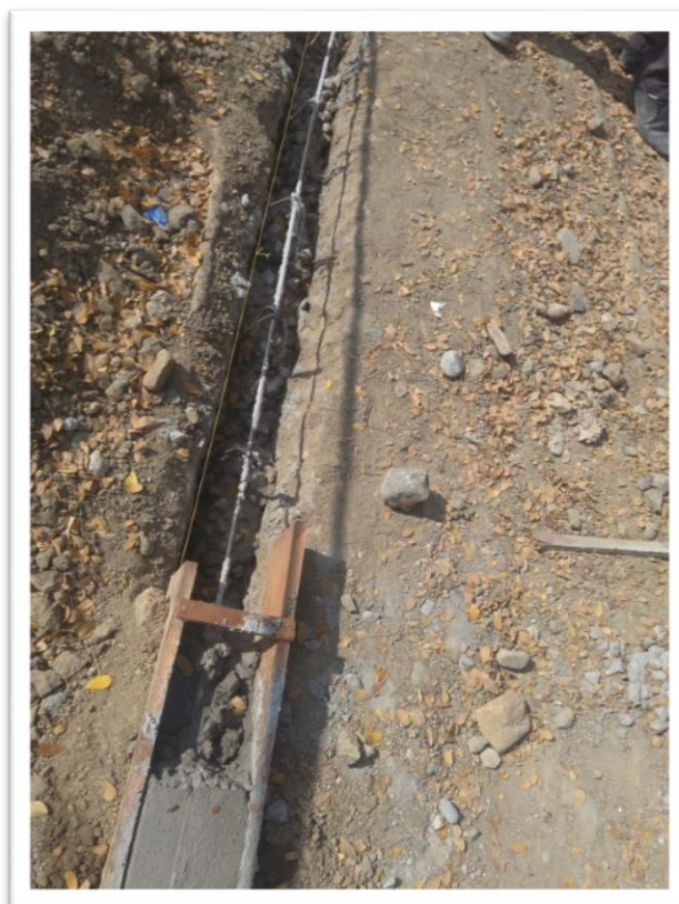
Figura 53. construcción sardinel
