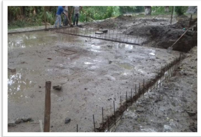
Figura 26. presencia de lodo e inundaciones por lluvias
