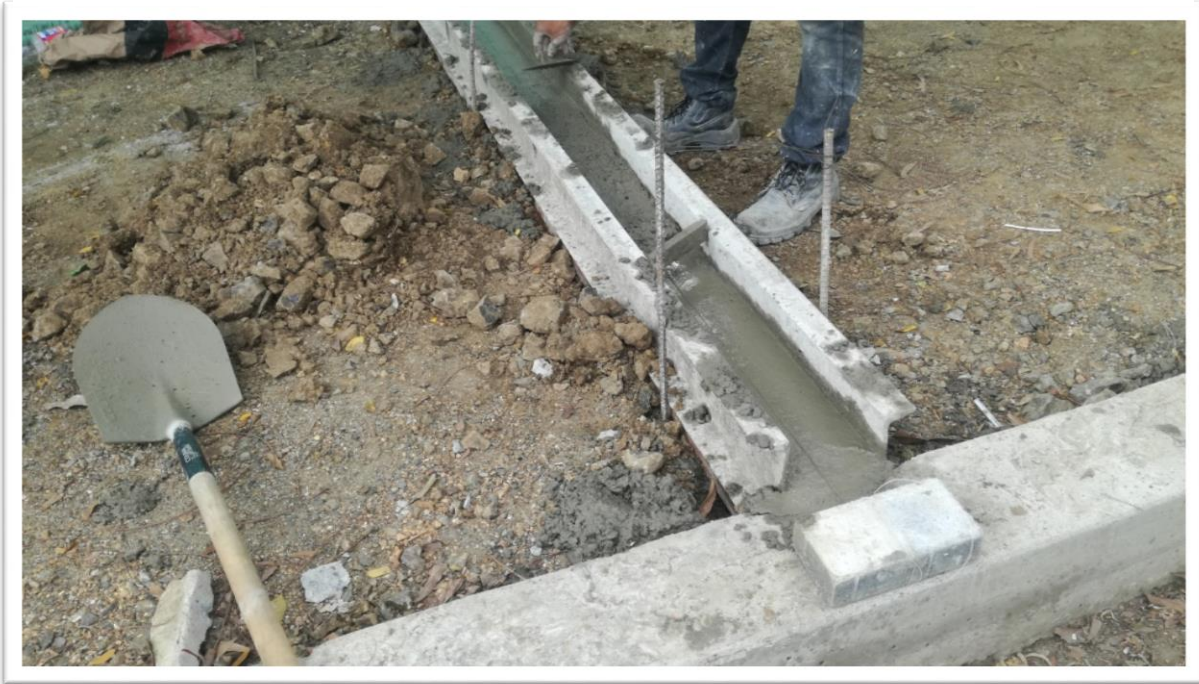
Figura 18. Construcción de sardineles intermedios
