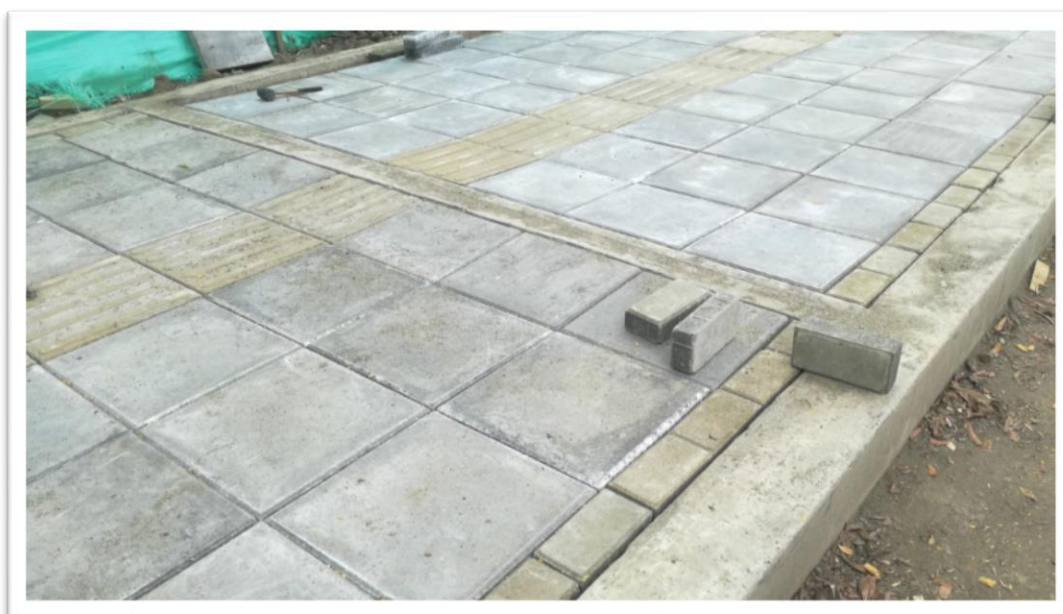
Figura 21. Conformación total de loseta gris y loseta táctil con bordillos
