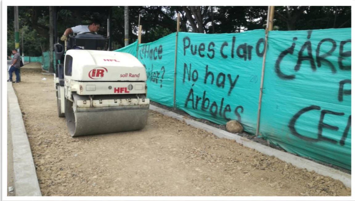
Figura 15. Compactación del terreno, capa de 10cm en roca muerta
