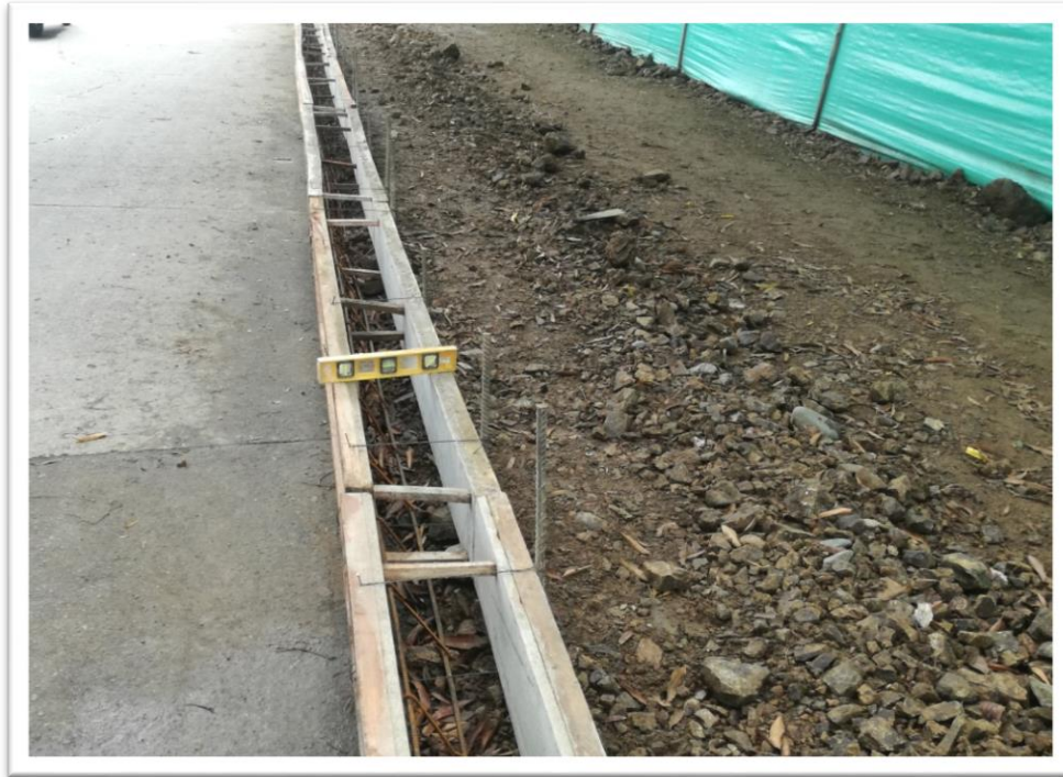
Figura 14. Sardinel 20x25 cm en concreto de 3000 psi con acero 60000 psi
