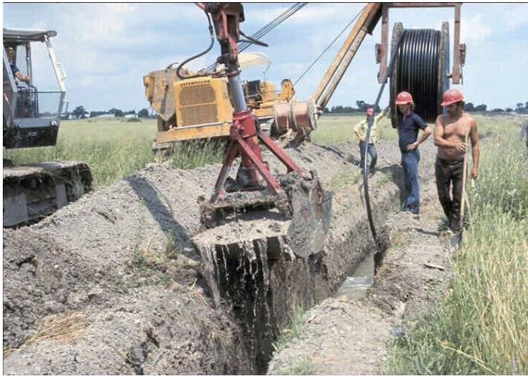
IMAGEN 2.7 Excavación con cucharón de almeja
