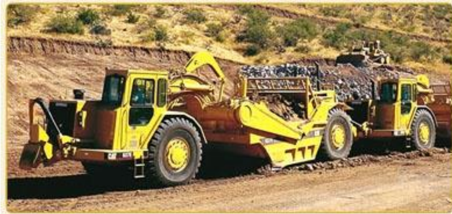
IMAGEN 5.39 Mototraílla cortando y cargando
