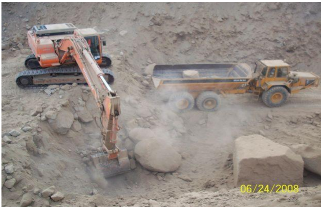
IMAGEN 5.25 Retroexcavadora sobre material a excavar
