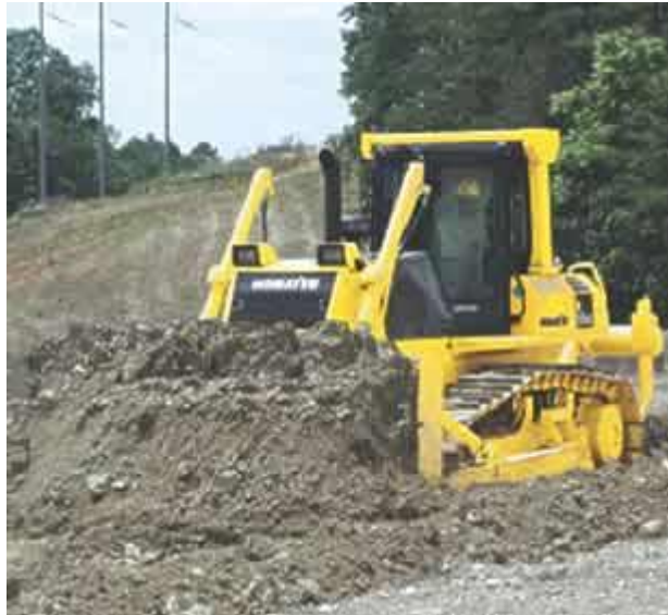
IMAGEN 2.12 Extendido con tractor sobre orugas
