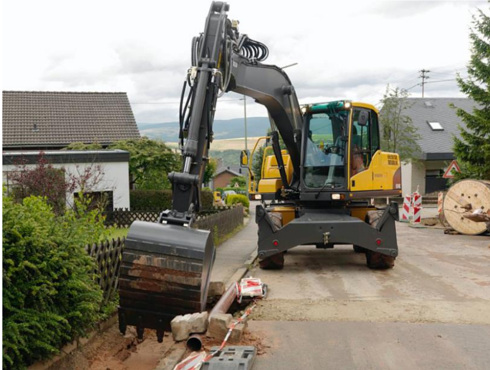
IMAGEN 5.19 Retroexcavadora sobre llantas
