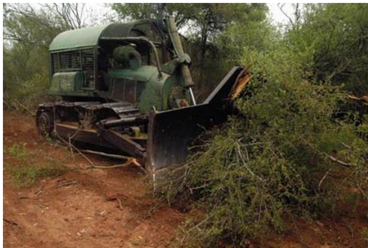
IMAGEN 2.1 Desmonte y desbroce con angledozer
