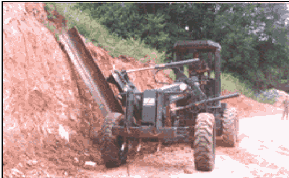
IMAGEN 5.45 Motoniveladora perfilando talud
