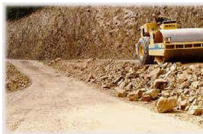
IMAGEN 2.13 Compactación con rodillo mixto
