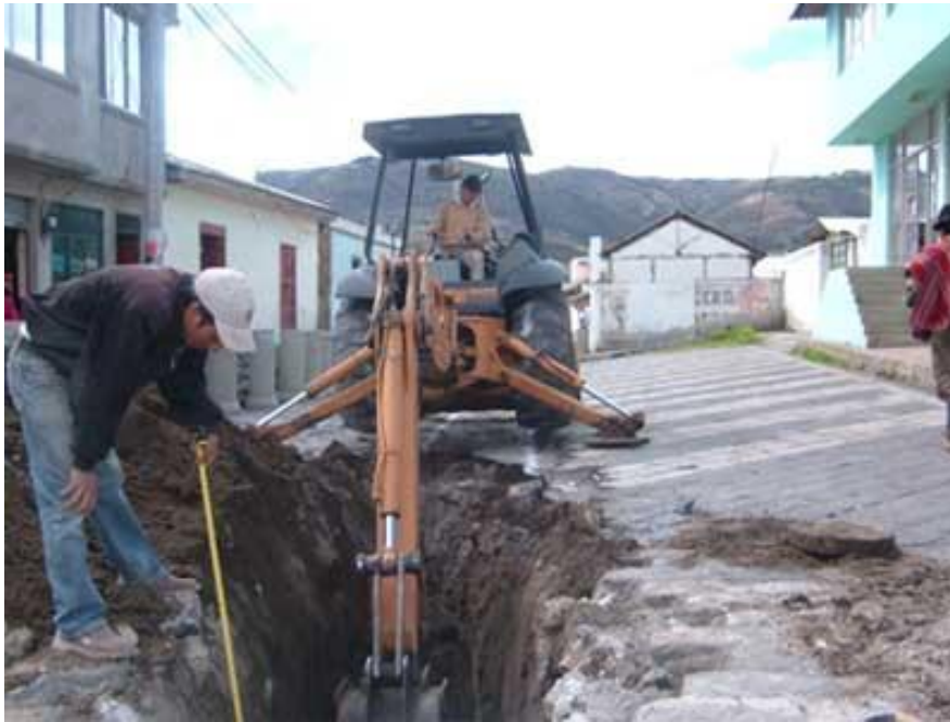
IMAGEN 5.13 Retroexcavadora cargadora zanjando
