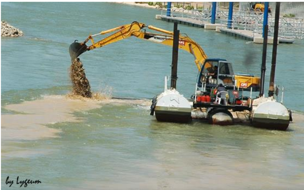
IMAGEN 5.30 Draga hidráulica excavando
